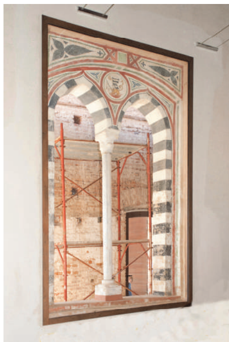
Fig. 16, vista interna della bifora nella terza sala del corpo basso
