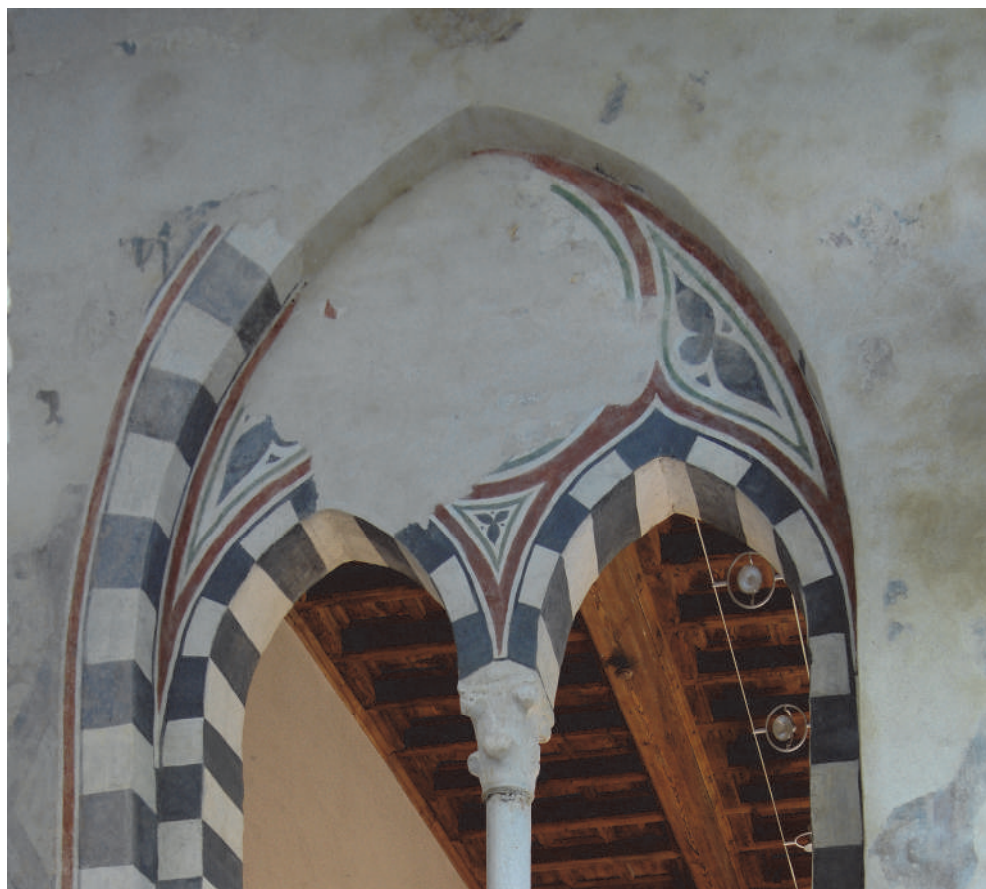
Fig. 15, la lunetta della bifora nel lato esterno del corpo basso, presenta una vistosa caduta d'intonaco
