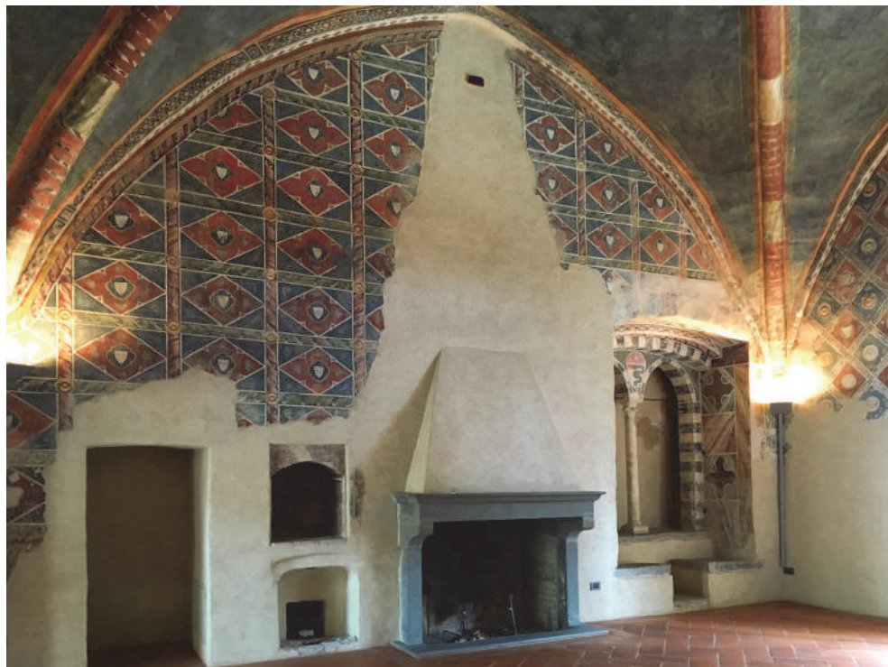
Fig. 6, al piano terreno, Sala di Beatrice d'Este, con un rustico camino di fattura recente accanto a una bifora, ora murata.
